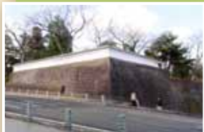
2 大手門北側土塀(現存建築物)
