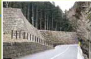
6 本丸西北石墙
